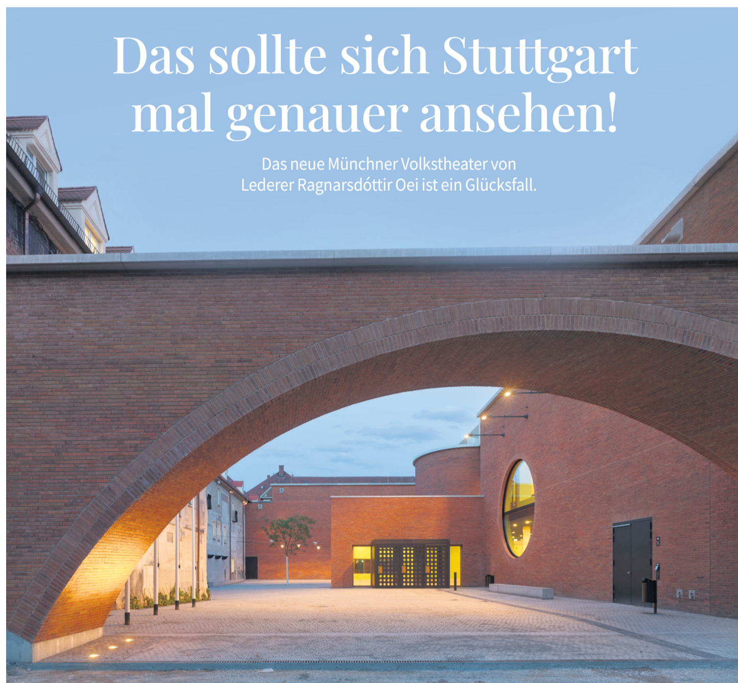
Hereinspaziert! Der Hof des neuen Münchner Volkstheaters mit dem Haupteingang
